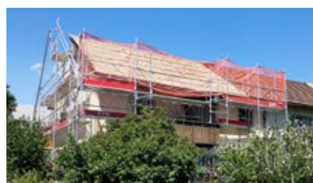
Erste Massnahme vor der Sanierung: das Notdach
