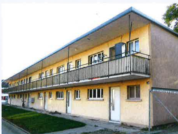
Blick auf das Laubenganghaus unmittelbar vor dem Abbruch im Herbst 2017. (Bild: Peter Niederhäuser)
