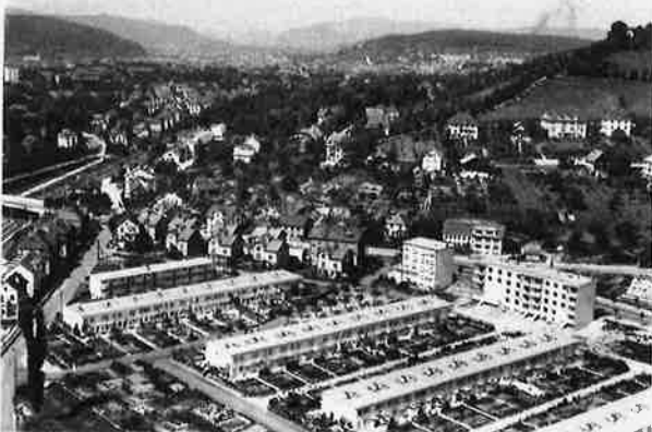
Blick über die Wohnkolonie Stadtrain Richtung Stadtzentrum; der hinterste Block ist das Laubenganghaus am Spitzweg. Luftbild von Walter Mittelholzer 1934. (Bild: Bildarchiv ETH-Bibliothek Zürich)
